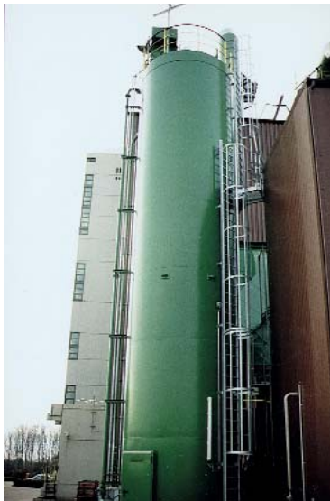
Siloanlage für die Kalkmilchdosierung in Kläranlagen
